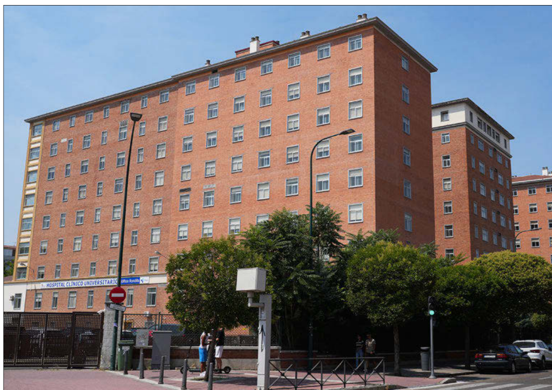
Edificio Rondilla en Valladolid que acogerá la primera unidad multidisciplinar de ELA en Castilla y León. E.M.
